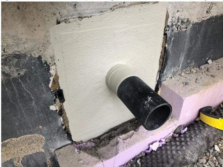
Wir arbeiten mit Flüssigkunststoff der Sorte PMMA (Polymethylmethacrylat).
