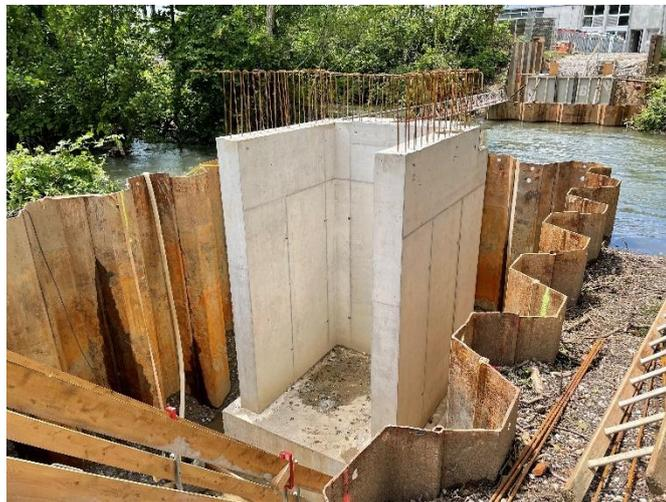
\* Eine Spundwand ist ein Verbau zur Sicherung von Baugruben, der zugleich eine Dichtungsfunktion übernehmen kann.
